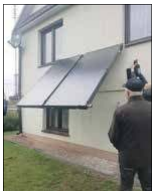
W 146 domach w gminie zainstalowano panele solarne, za kwotę 1 mln 413 tys. zł, dofinansowanie wyniosło 85 proc. całej inwestycji
