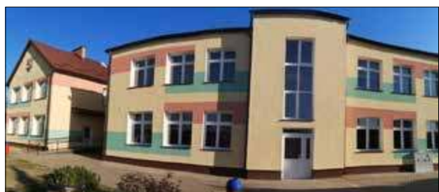
Budynek Zespołu Szkół w Sławatyczach został ocieplony, założono w nim też instalację fotowoltaiczną oraz wymieniono okna
