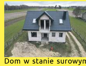
Dom w stanie surowym otwartym, Wólka Siemieńska, 885 851 160
