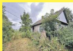
Działki budowlane w miejscowości Tchórzew, 885 851 158
