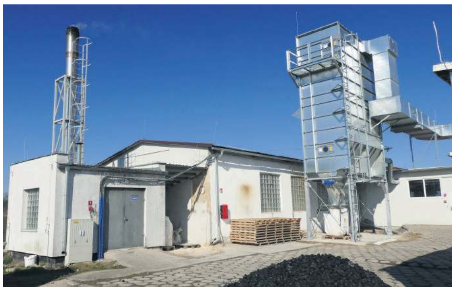
W miejsce obecnej kotłowni ma powstać nowa
