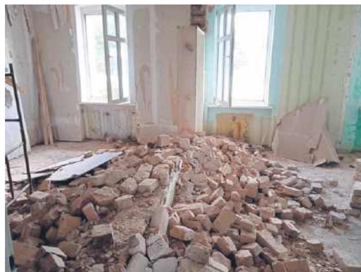
Wykonawca miał co wyburzać. Z trzech pokoi powstała przestronna sala. Fot. SP Iwiec
