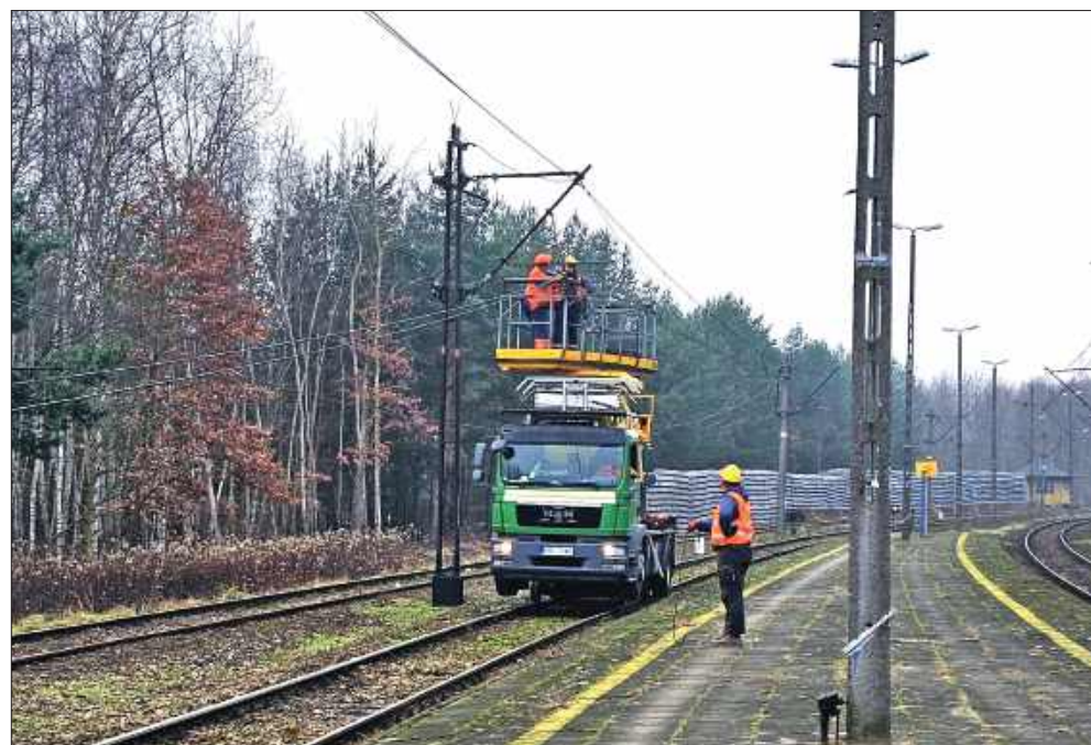
Demontaż sieci trakcyjnej w stacji Sobów.
