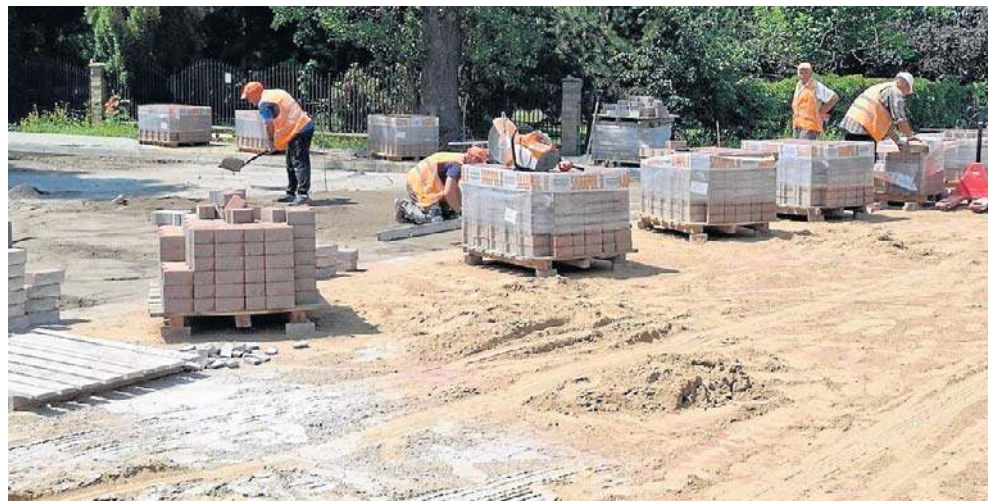
Na jednym ze skrzyżowań modernizowanej ulicy Idalińskiej w Radomiu trwa przebudowa skrzyżowania.
