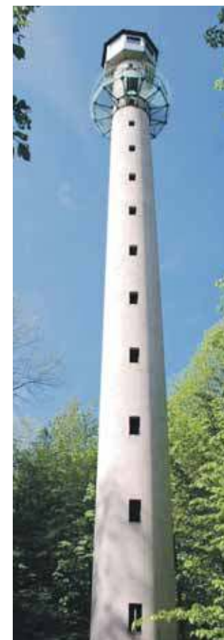
Wieża ma 36 m, aby na nią wejść, trzeba pokonać ponad 140 stopni
