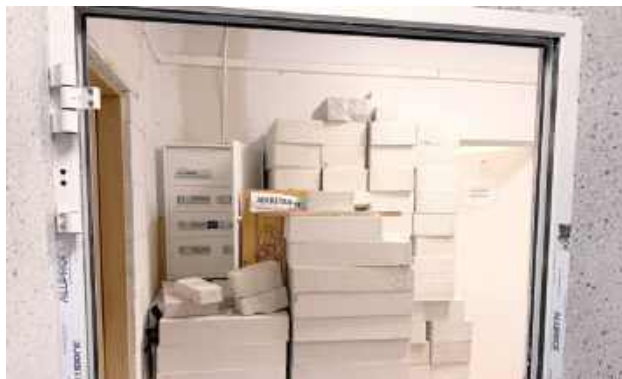
Remont w Milejowie - dojście do sekretariatu
