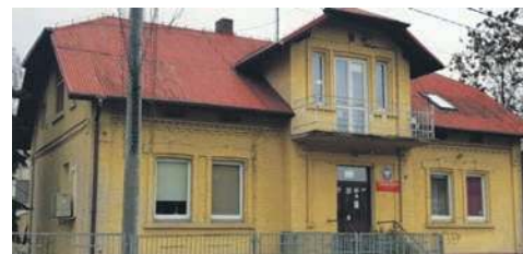
Za trzy lata libiąscy policjanci powinni opuścić ten zabytkowy budynek, w którym mieści się komisariat
