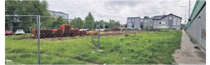
W tym miejscu ma powstać parking, będący częścią centrum przesiadkowego w Trzebini
