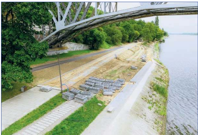
Przebudowa drugiego odcinka nadwiślańskich bulwarów potrwą do sierpnia przyszłego roku
