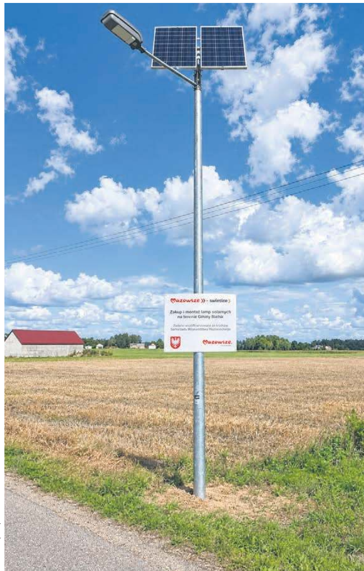
W 2026 roku na terenie Gminy Bielsk zamontowanych zostanie 114 nowych, energooszczędnych lamp solarnych
