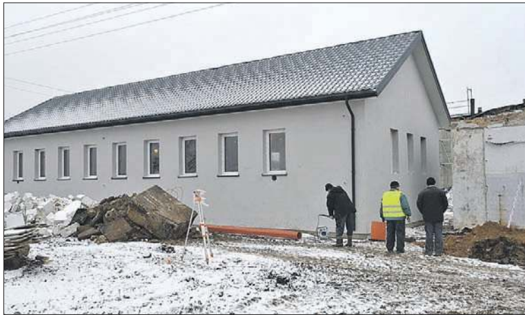
W Halasach powstaje stacja uzdatniania wody
