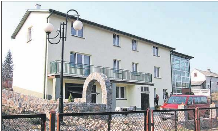
W ramach projektu wyremontowane zostaną Dom Nauczyciela w Kopytowie i Agromówka w Zabłociu na mieszkania socjalne. Oprócz tego pozyskane pieniądze będą wykorzystane na wyposażenie WTZ i ŚDS w Kodniu oraz prace remontowe w ich siedzibie (na zdjęciu)
