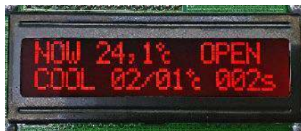
Fotografia 2. Wygląd wyświetlacza w trakcie pracy układu
