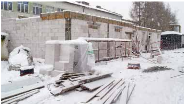
Budowa Powiatowego Centrum Opiekuńczo-Mieszkalnego w Mławie
