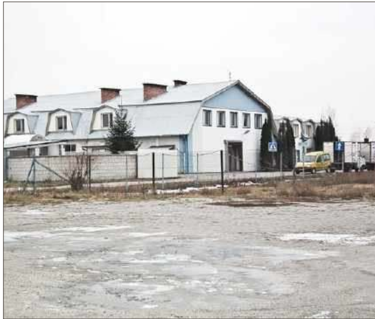
Nowy zakład produkujący wyroby mięsne powstanie w tym budynku.
