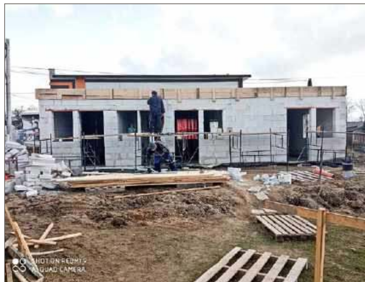
Budowa pomieszczeń dla sportowców w Wiewiórcie.
