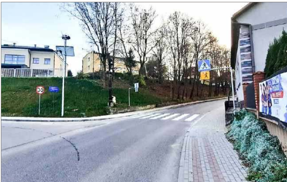
Radny chce, by przebudowane zostało m.in. przejście na skrzyżowaniu Mysłowskiego i Zielonej.
