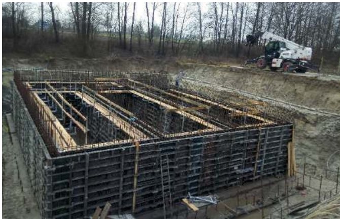
Jeden z etapów budowy podziemnego zbiornika oczyszczalni
