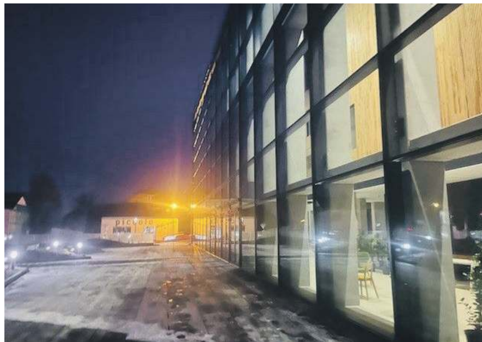
Wieczorny widok na siedzibę nowej biblioteki w Trzebini
