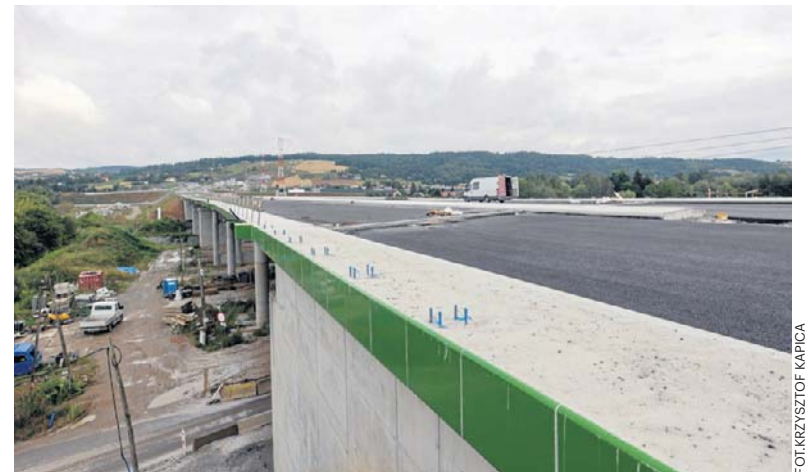
Prace przy budowie drogi S19 na odcinku Babica - Jawornik
