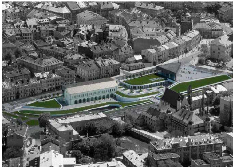
Arkady nie rezygnują z planu budowy na działce między Lubartowską a Świętoduską kompleksu parkingowo-usługowego i ciągle liczy na polubowne rozstrzygnięcie sporu
