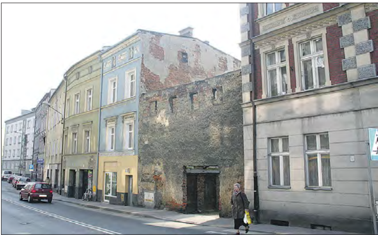
Prawdopodobnie gdzieś w tym miejscu znajdował się XVI-wieczny cmentarz morowy w Prudniku
