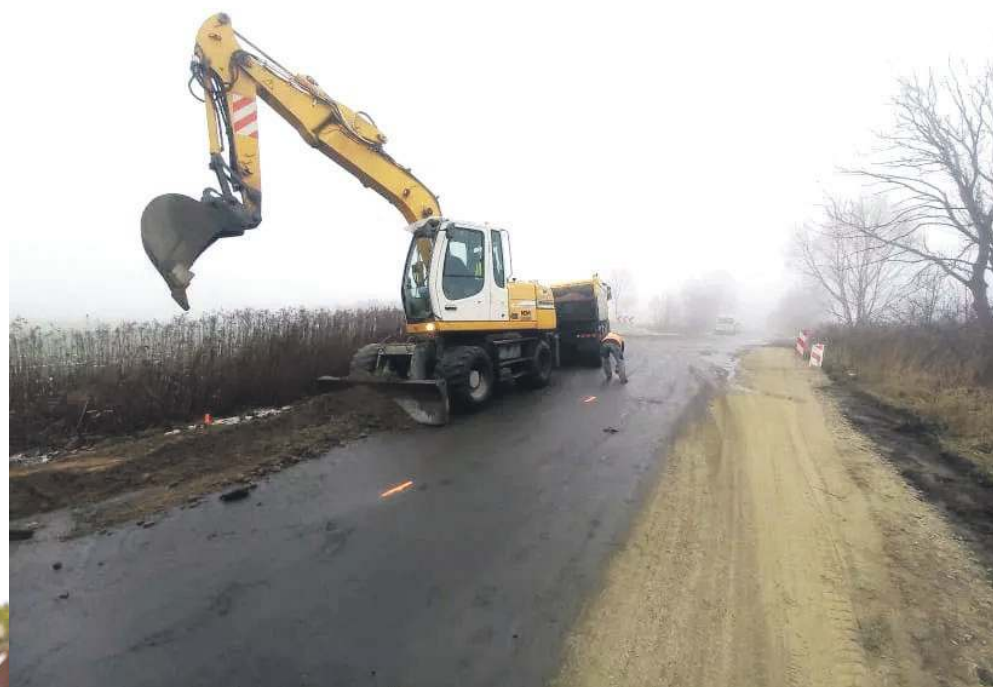
Remont drogi powiatowej w Lubnowie (Gmina Oborniki Śląskie)
