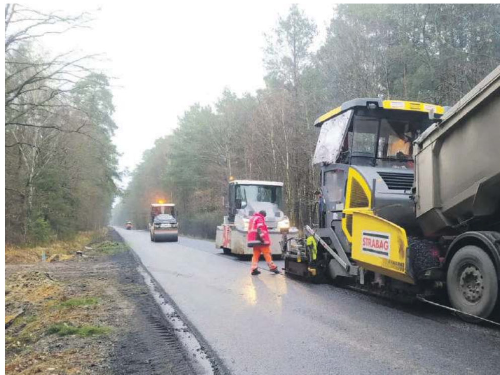
Przebudowa drogi powiatowej nr 1400D (Gmina Trzebnica)
