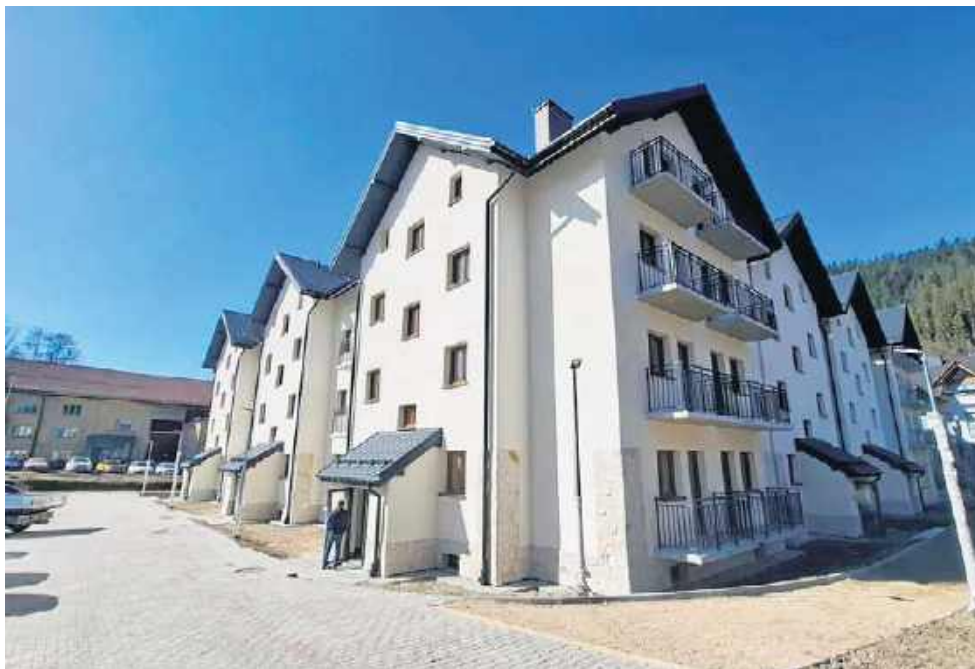
Ostatnia inwestycja dla mieszkańców to Kamieniec (na zdj.). Budynek jest na finiszu
