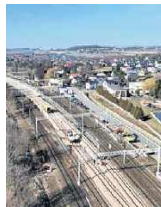
Modernizowana jest m.in. stacja Kraków Batowice
