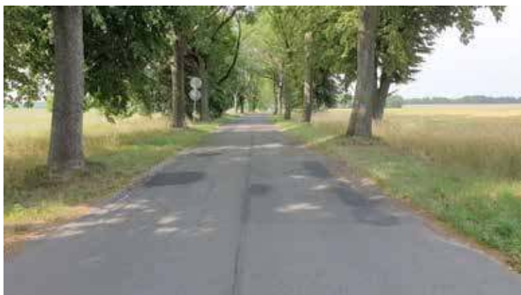
III etap przebudowy drogi powiatowej, niestety, ale nie będzie w tym roku przebudowywane
