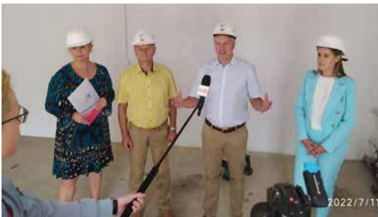
W trakcie spotkania inaugurującego prace od lewej dyrektor MBP A. Wysoszyńska, radny S. Saniuk, burmistrz R. Czapla oraz szefowa firmy budowlanej z Żabowa D. Józefiak
