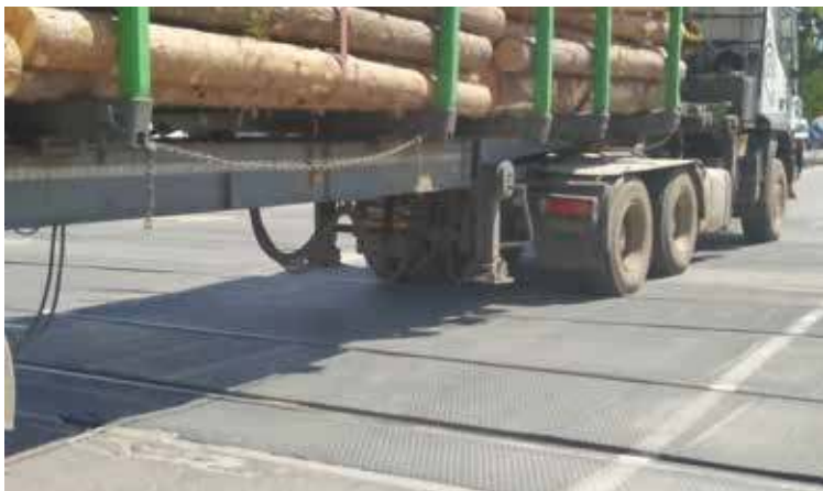
W dużej mierze za wyeksploatowanie nawierzchni przejazdu odpowiadają ciężkie pojazdy transportowe
