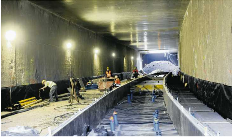
• Budowa tunelu dla tramwajów do Dworca Zachodniego
