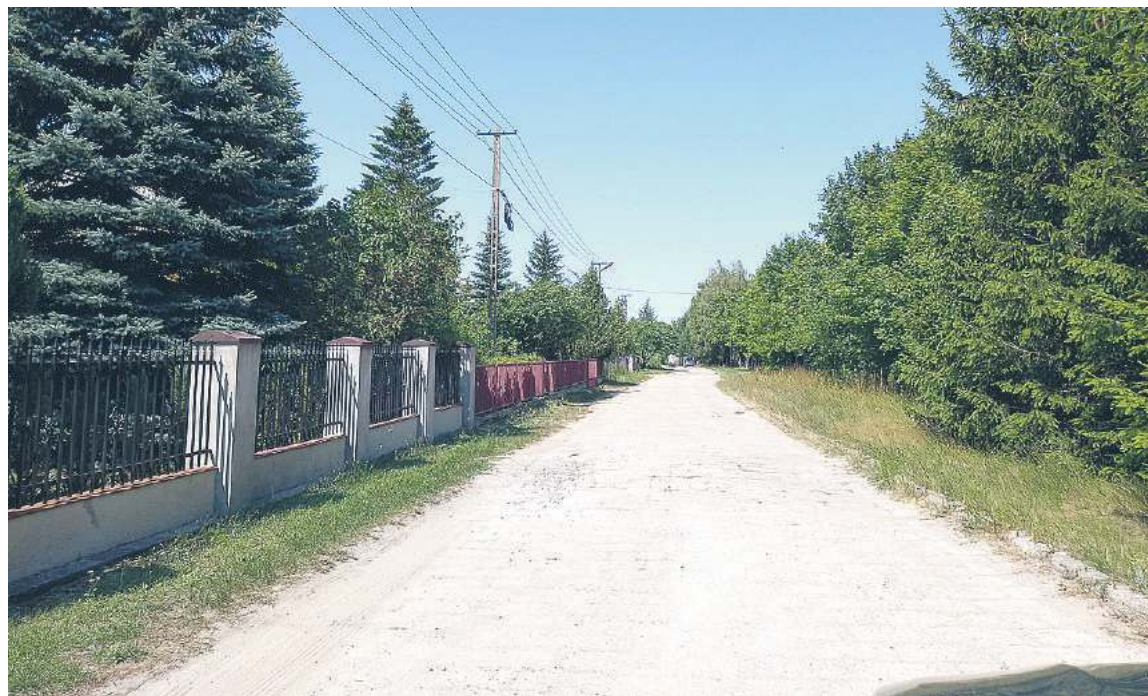
Stary Brus - m.in. ta droga zostanie przebudowana, tj. zostanie wykonana nakładka bitumiczna
