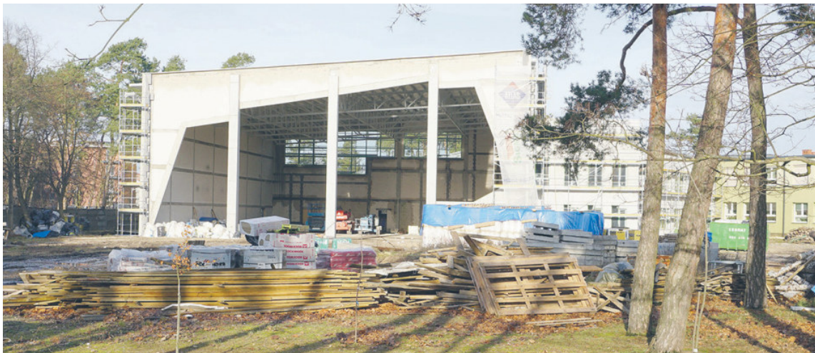
Budowa sali gimnastycznej w Węgrowie
