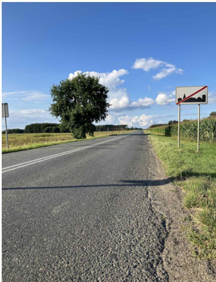
Ten odcinek drogi wojewódzkiej nr 338 już za chwilę przejdzie gruntowną przebudowę
