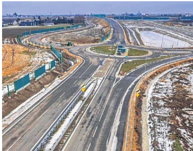
Potrzeba kilku dni sprzyjającej aury. Malowanie w warunkach zimowych nie wchodzi w grę
