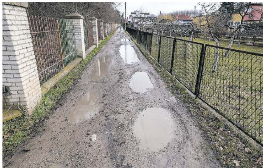
... i przed remontem...
