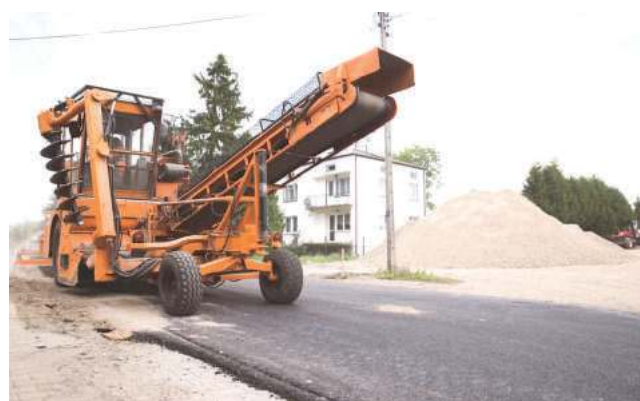
Prace związane z przebudową drogi Kurów-Karmanowice idą pełną parą. To jedna z najdroższych inwestycji w gminie Wąwolnica w tym roku. Całość zostanie ukończona już w przyszłym miesiącu
