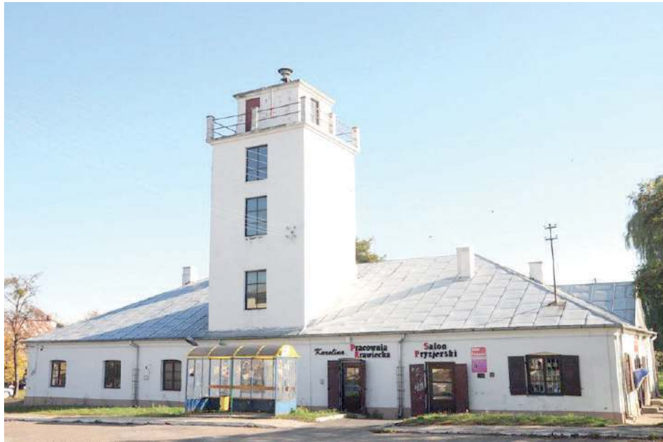
Ratusz tuż przed remontem z charakterystyczną wieżą strażacką, która zniknęła w trakcie rewitalizacji
