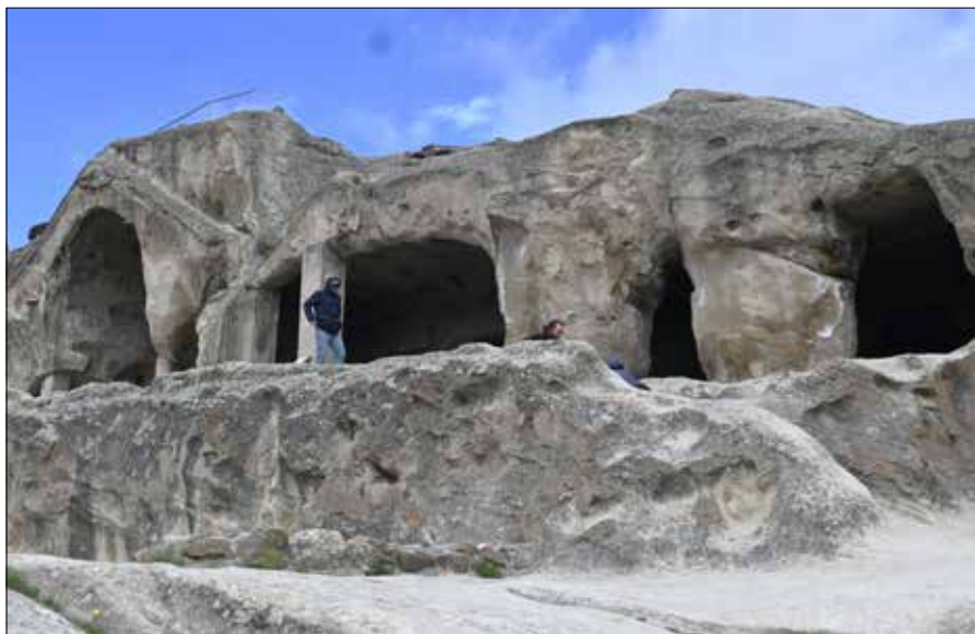
W skałach wykuto sale zgromadzeń, magazyny, świątynie, piwnice na wino, a także rozbudowany system komunikacyjny
