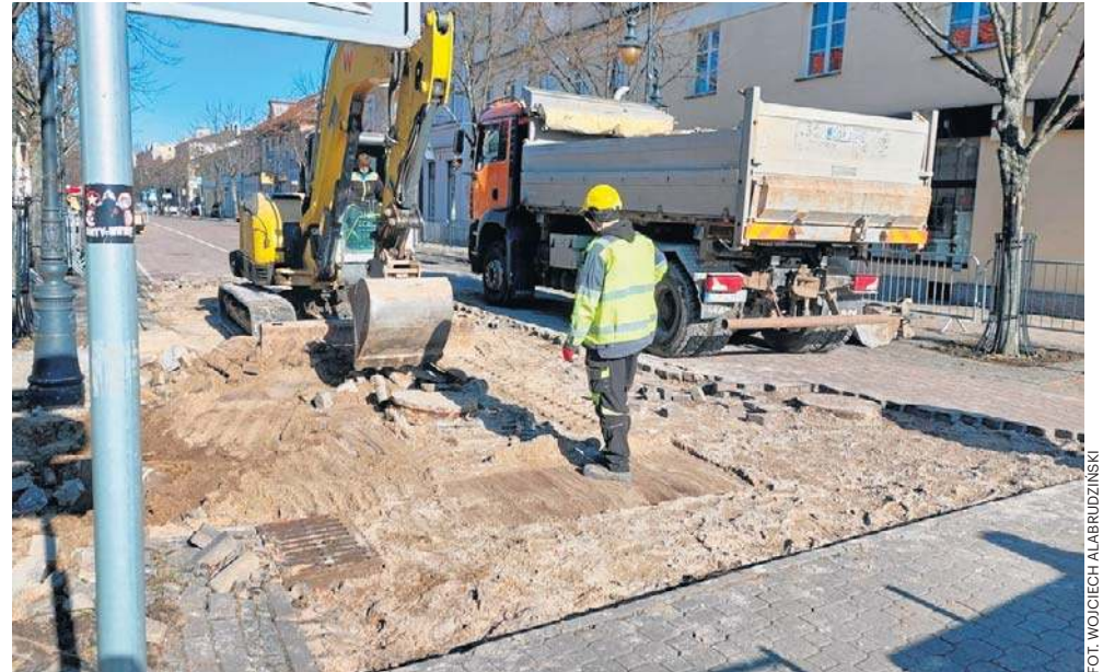
Ekipy remontowe rozpoczęły inwestycję od strony placu Wolności
