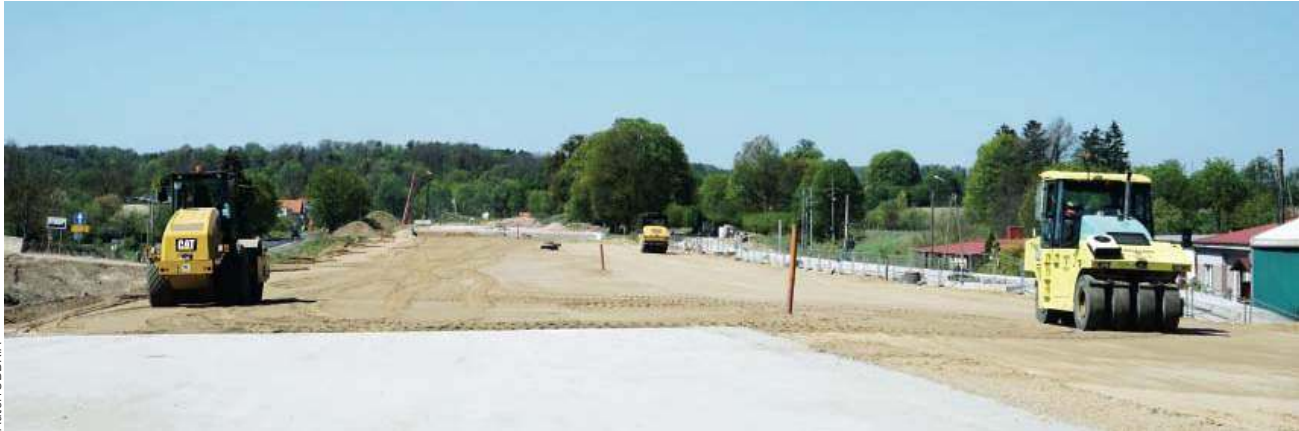
Budowa S16 na odcinku Borki Wielkie – Mrągowo powoli zbliża się do końca
