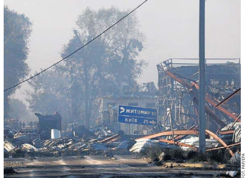
Pociski uderzyły w miejscowości Myła w pobliżu Buczy. Uszkodzone zostały także dom opieki oraz budynki prywatne
