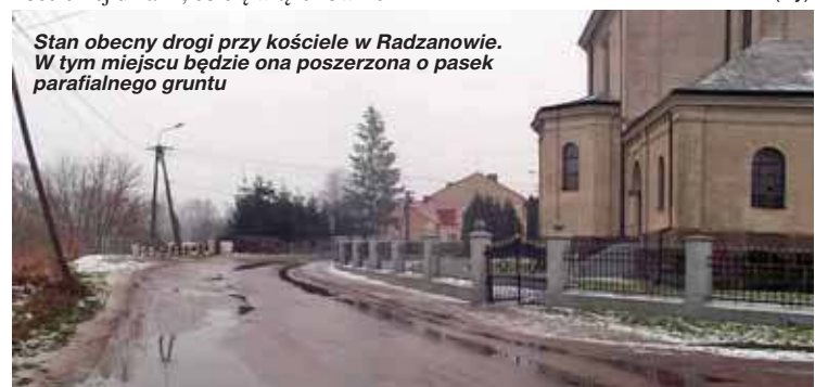
Stan obecny drogi przy kościele w Radzanowie. W tym miejscu będzie ona poszerzona o pasek parafialnego gruntu
