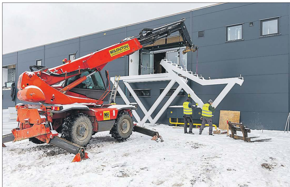
W zeszłym tygodniu trwał montaż zewnętrznych zejść z trybun
