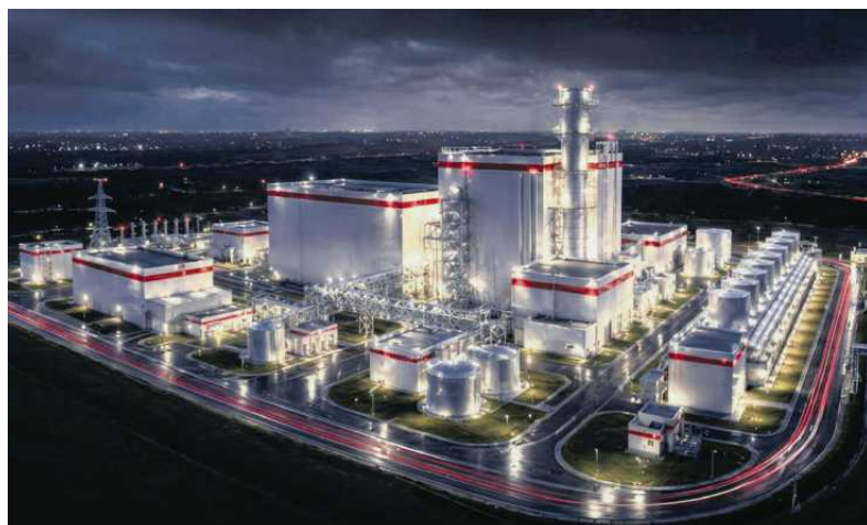
• Elektrownia gazowo - parowa w Gdańsku FOT. MATERIAŁY PRASOWE ENERGA SA
