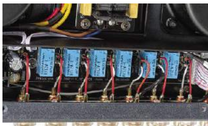
Przełączniki wyboru wejść znajdują się przy tylnej ściance, tuż za gniazdami RCA, stąd sygnały płyną do przedniej ścianki długimi przewodami.
