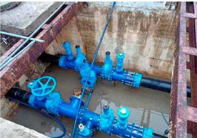
Pegimek jest w trakcie realizacji modernizacji magistrali wodnej w Świdniku. Inwestycja zakłada m.in. wymianę 11-kilometrów wodociągu, wymianę 21 komór zasuw oraz montaż w magistrali światłowodu i modernizację systemu sterowania studniami. Prace, które mają się zakończyć w kwietniu tego roku będą kosztować ponad 10 mln zł, z czego 7 mln pokryje unijne dofinansowanie
