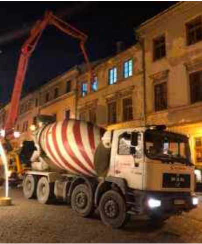
Prace przy przebudowie kamienicy przy ul. Grodzkiej 16
