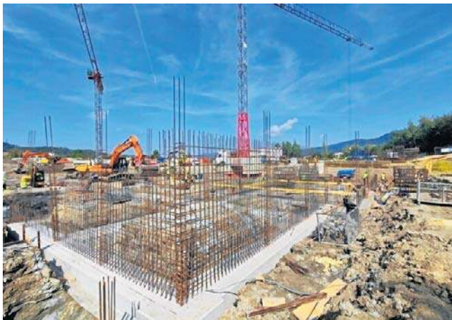
Trwa budowa koszar dla żołnierzy WOT w Limanowej. Inwestycja ma być gotowa pod koniec 2024 roku
