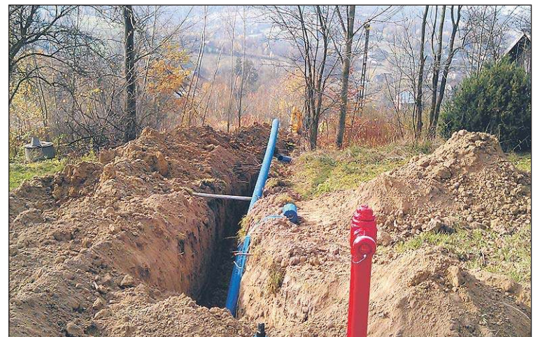
Gminie Dębica dofinansowanie przydałoby się na wykonanie brakujących odcinków kanalizacji w Stasiówce i Stobiernej. (fot. archiwum)
