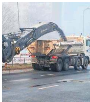
Prace wznowiono po zimowej przerwie
