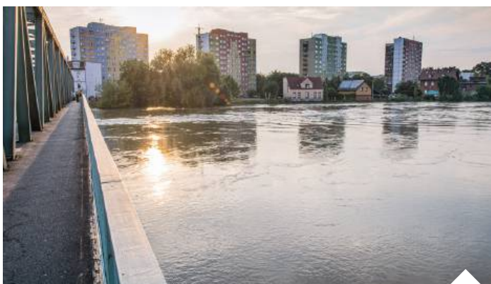
Pomimo postępu technologicznego i rozwiniętych systemów zabezpieczeń przed powodzią nie możemy liczyć na to, że na terenie zalewowym powódź nie wystąpi | fot. Bartłomiej Kudowicz/Forum
