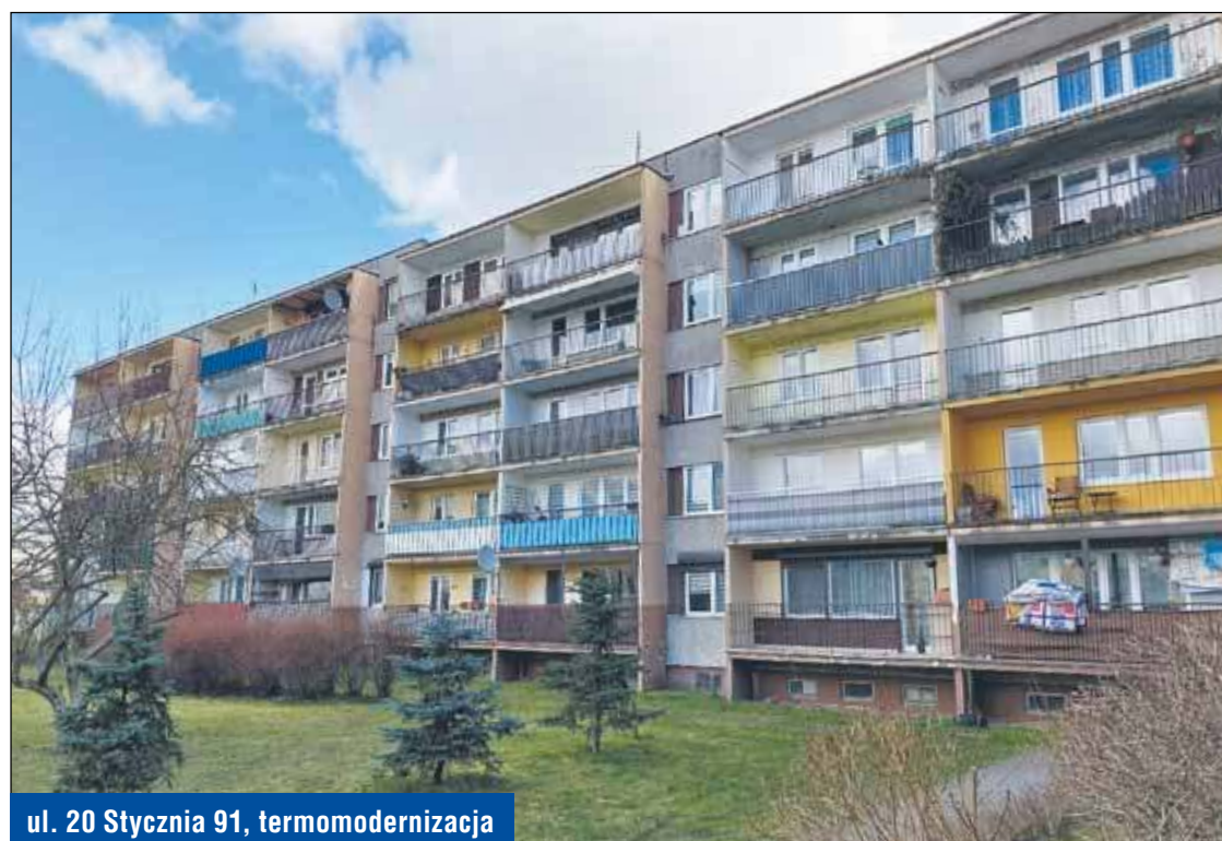
ul. 20 Stycznia 91, termomodernizacja
