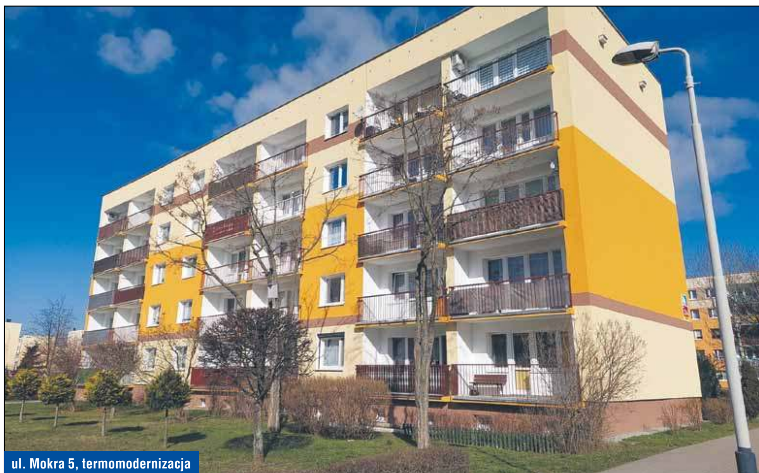
ul. Mokra 5, termomodernizacja
