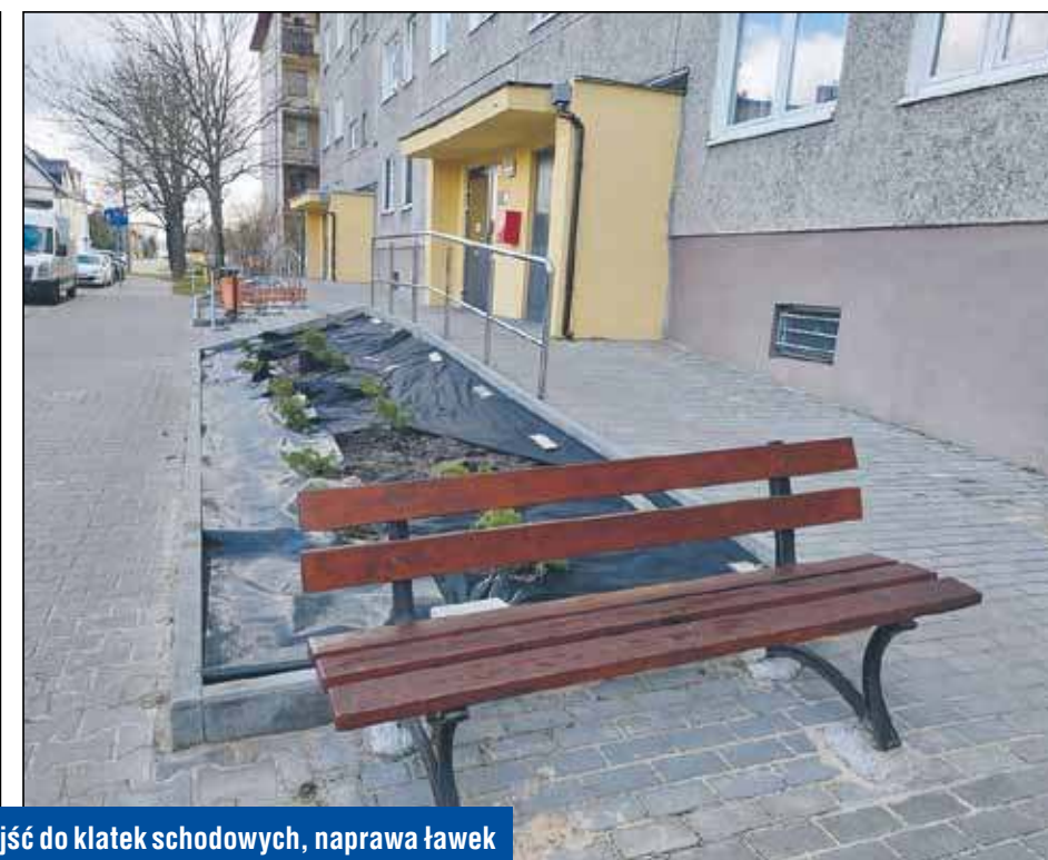
ul. Bracka 69/71, naprawa schodów i dojść do klatek schodowych, naprawa ławek
