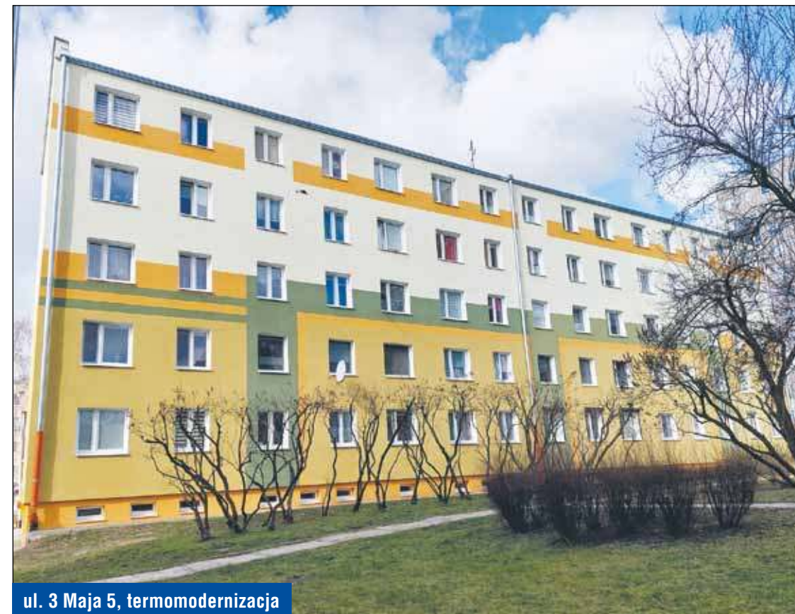
ul. 3 Maja 5, termomodernizacja
