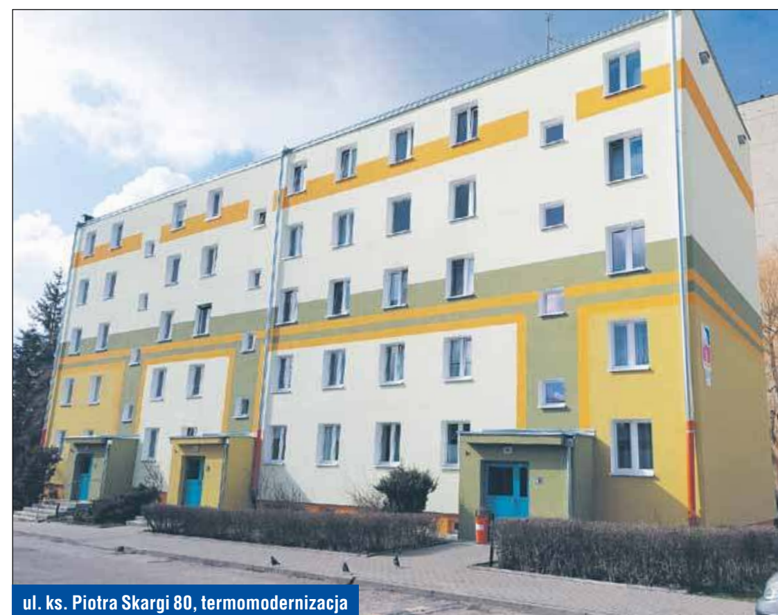
ul. ks. Piotra Skargi 80, termomodernizacja
