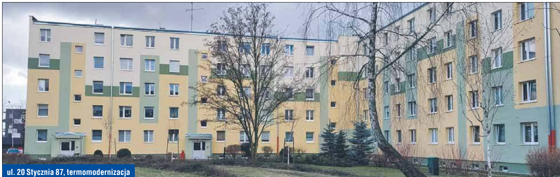
ul. 20 Stycznia 87, termomodernizacja
