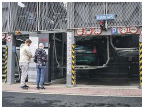
Wjazd do parkingu automatycznego Fot. Grzegorz Bargiela wKatowicach.eu
