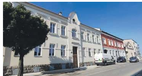
Wyremontowana fasada kamienicy przy ul. 3 Maja 5 w Chrzanowie
