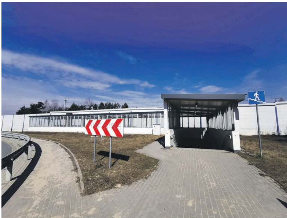
Przeście podziemne w Młoszowej
