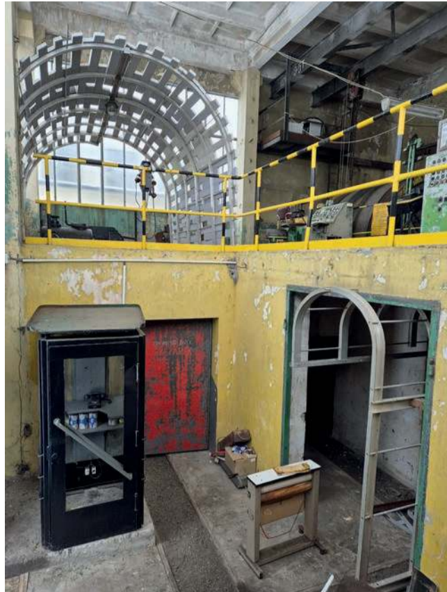
Maszynownia: z wykorzystywaną pod ziemią budką telefoniczną i fragmentem zabezpieczeń kopalnianego korytarza
