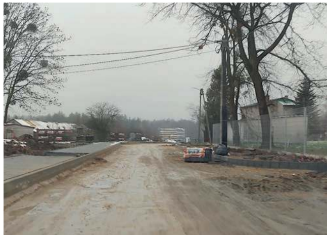
Budowana droga w chrzanowskim Kroczymiechu
