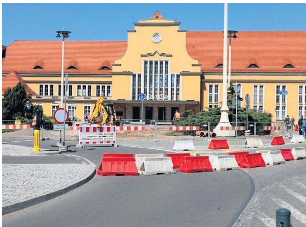
Roboty przy dworcu poważnie utrudniły dojazd podróżnych
