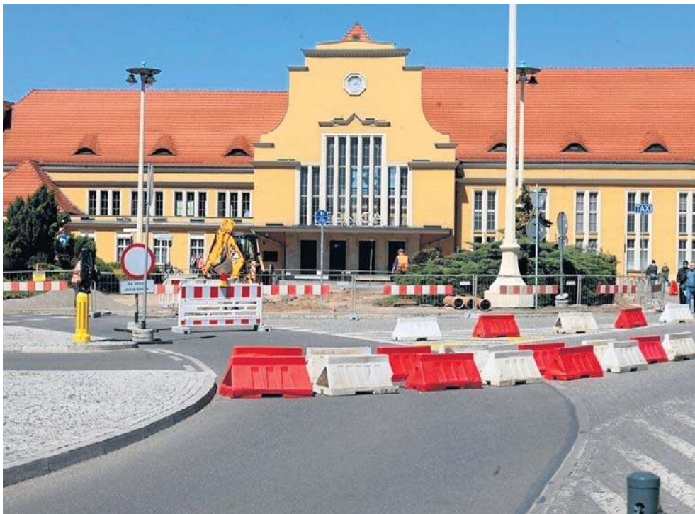
Roboty przy dworcu poważnie utrudniły dojazd podróżnych
