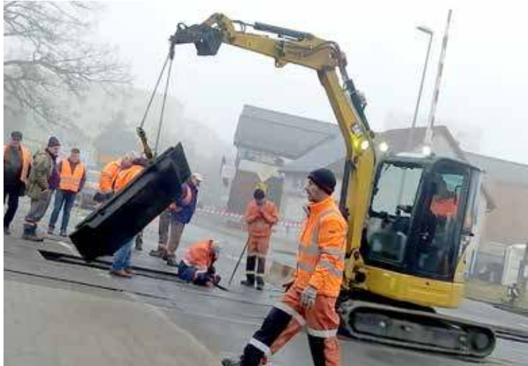
Prace na przejeździe kolejowym
