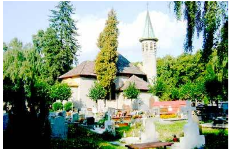
Zabytkowa kaplica po wielu miesiącach prac przygotowawczych będzie mogła przejść remont
