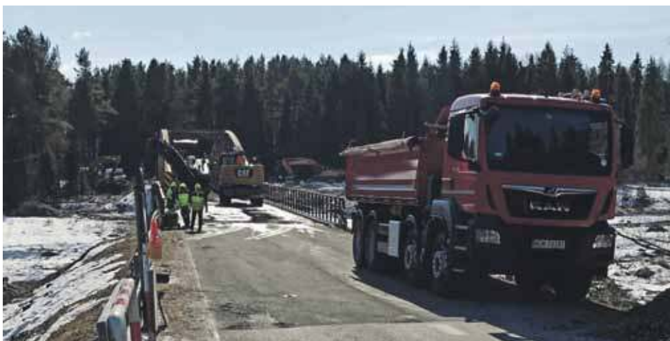
Ruszyły prace rozbiórkowe na moście w Trybszu
