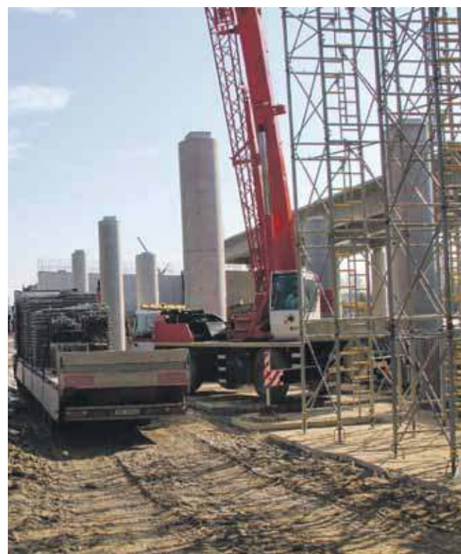
Filary ostatniego odcinka zakopianki przechodzącej przez Bór Kombinacki. Droga ma być przejezdna za półtora roku.
