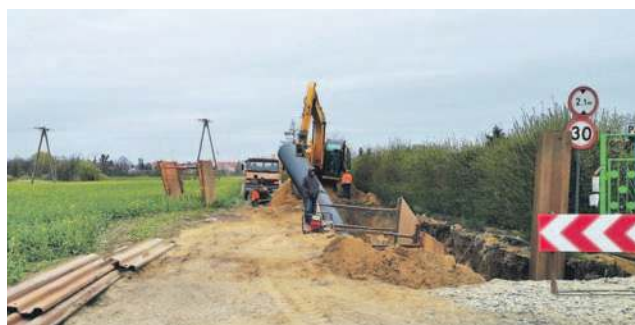
Budowa kanalizacji trwa
